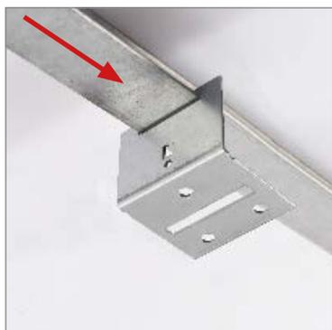
1. Insérer la suspente sur le porteur clip en la faisant glisser depuis l'extrémité.
