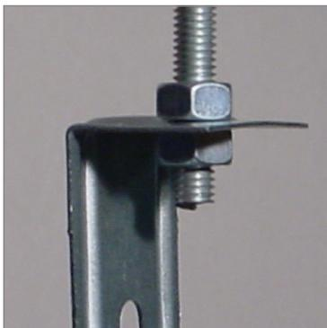
**1.** Fixer l'attache à une tige filetée à l'aide de 2 écrous.
