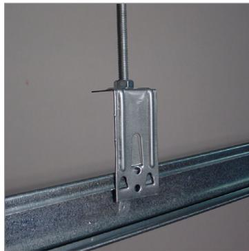
**2.** Poser le porteur sur les 2 crochets inférieurs en les insérant dans le rabat supérieur du porteur.
