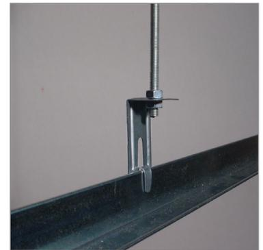
**3.** Plier la languette supérieure sur le porteur afin de serrer le montage.
