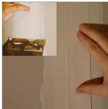
2. Appliquer la bande en la centrant sur l'axe du joint. Puis serrer la bande avec la spatule pour éliminer l'excédent d'enduit.
