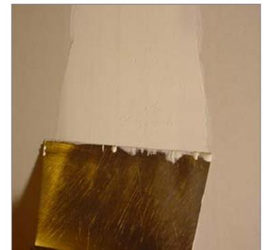
3. Enduire une seconde couche d'enduit de remplissage jusqu'à obtenir une surface parfaitement lisse.
