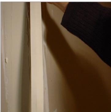
**1.** Mesurer la longueur de bande nécessaire et garnir les joint d'enduit entre les bords amincis des plaques.
