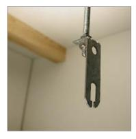
1. Visser un écrou sur la tige filetée à la hauteur souhaitée, puis venir positionner le coulisseau en butée de cet écrou en insérant la tige filetée dans le trou d'accrochage. Serrer le montage en vissant un second écrou sous le coulisseau.
