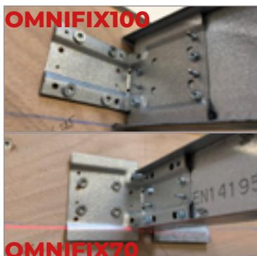
**1.** L'EMBOUT possède 2 ailes de dimensions différentes pour les 2 hauteurs d'OMNIFIX. Dans le sens désiré, fixer le premier EMBOUT sur le support à l'aide des 4 trous diamètre 7 mm et de vis et chevilles adaptées.
