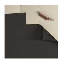
2. Coller les autres parties de membranes en veillant à ce que les lés soient bien bord à bord. Visser la deuxième plaque de plâtre à l'aide de vis TTPC.
