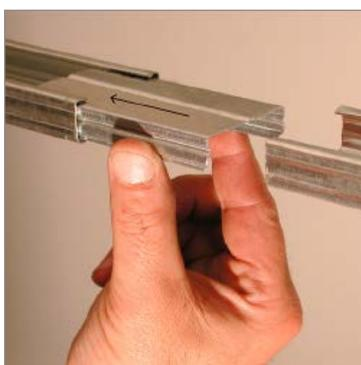
2. Enclencher le raccord dans la fourrure jusqu'au blocage de l'ergot.
