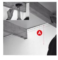
1. Après le traçage de la hauteur de l'ossature (A), repérer le niveau des suspentes par rapport au sol, pré-positionner les avec les griffes ou les trous oblongs et les fixer ensuite avec les vis.
