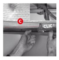
3. Ne jamais dépasser 1m20 entre les 2 suspentes pour une même fourrure (C). Clipser les ossatures sur les suspentes en engageant une aile dans la fente horizontale et pivoter vers vous jusqu'au CLIC. Rabattre si nécessaire les pattes anti-soulèvement.
