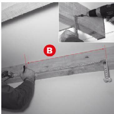
2. Mesurer les intervalles (B), selon le mode de pose des plaques de plâtre par rapport à l'orientation des fourrures en respectant un écartement maximum de 60 cm.
