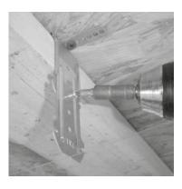
3. Si la hauteur de la suspente ne suffit pas, visser une suspente à l'aide d'une vis TRPF après réglage de la hauteur du plénum.
