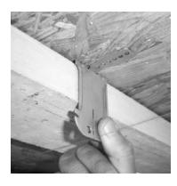
Positionner la suspente sur le talon de la poutrelle ou directement sur l'hourdis bois.
