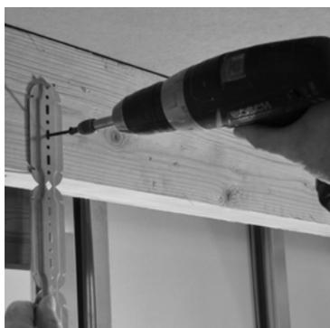
**2.** Après repérage du niveau, prépositionner directement les suspentes dans les trous oblongs. Les fixer définitivement, avec des vis adaptées au support dans les trous ronds.
