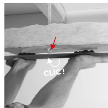
**3.** Clipser les fourrures sur les suspentes en engageant une aile dans la fente horizontale et pivoter vers vous jusqu'au CLIC.
