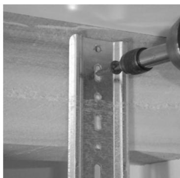
**1.** Après le repérage du niveau des suspentes, prépositionner dans les trous oblongs puis fixer définitivement la deuxième vis TTPC dans un trou rond.
