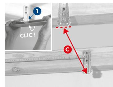
Ne jamais dépasser 1m20 entre les 2 suspentes pour une même fourrure (C). Clipser les ossatures sur les suspentes en engageant une aile dans la fente horizontale (I) et pivoter vers vous jusqu'au CLIC.
