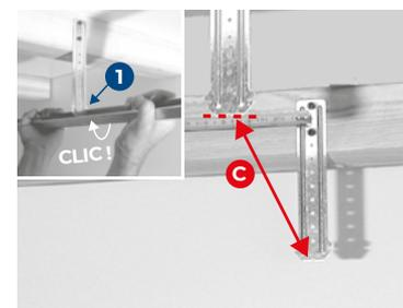
Ne jamais dépasser 1m20 entre les 2 suspentes pour une même fourrure **C**. Clipser les ossatures sur les suspentes en engageant une aile dans la fente horizontale **1** et pivoter vers vous jusqu'au CLIC.
