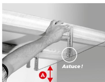
Après le traçage de la hauteur de l'ossature **A**, repérer le niveau des suspentes par rapport au sol et les fixer avec 2 vis.
