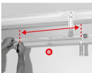
Mesurer les intervalles **B**, selon le mode de pose des plaques de plâtre par rapport à l'orientation des fourrures en respectant un écartement maximum de 60 cm.
