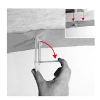
2. Faire pivoter l'onglet de la suspente à 90° pour permettrede retenir la laine de verre momentanément avant le clipsagede la fourrure.
