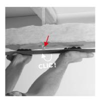
Clipser les ossatures sur les suspentesenengageant une aile dans la fente horizontale et pivoter vers vous jusqu'au CLIC.
