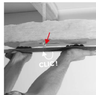
3. Clipser les ossatures sur les suspentes en engageant une aile dans la fente horizontale et pivoter vers vous jusqu'au CLIC.
